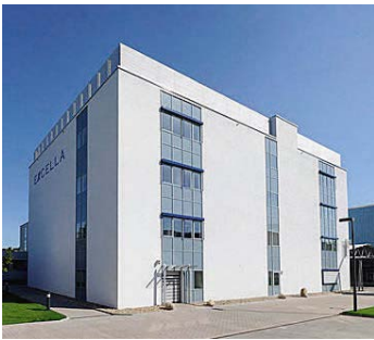
Das 2009 in Betrieb gegangene chemische Technikum zur Entwicklung und Herstellung pharmazeutischer Wirkstoffe.
